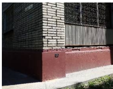
Рис. 3. Геодезические марки для контроля осадок здания: a – вид марки; б – размещение марки на цоколе здания
